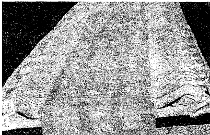
Рис. 5. Один из плоских линейных индукторов насоса.
